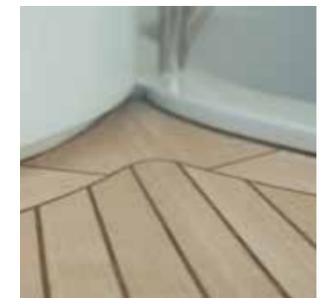
junta ranura. La boquilla se coloca en el fondo de la costura, manteniendo la pistola aplicadora en un ángulo de 60 ° a 80
