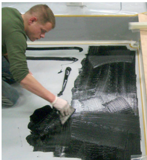
Aplicación de Sikaflex®-298
