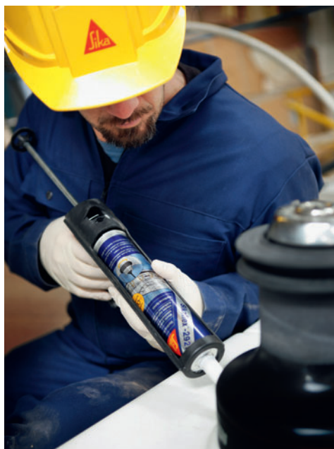
Aplicación del Sikaflex®-292i
