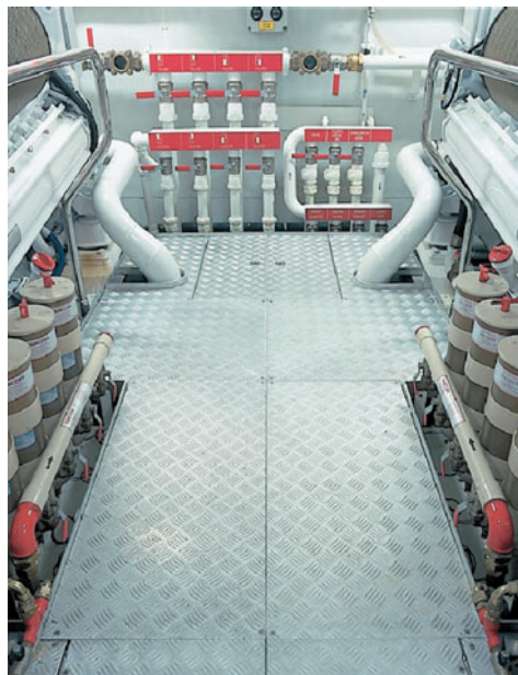
Suelo de sala de máquinas
